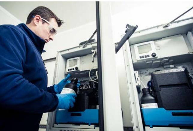
Die Überwachung des Phosphorgehaltes übernehmen Analysatoren. Zuverlässige Online-Messung, eine präzise Fällmitteldosierung und die erweiterte Diagnose per Fernzugriff erhöhen die Prozesssicherheit. Maik Brückner von BNA führt die regelmäßigen Wartungen durch.
