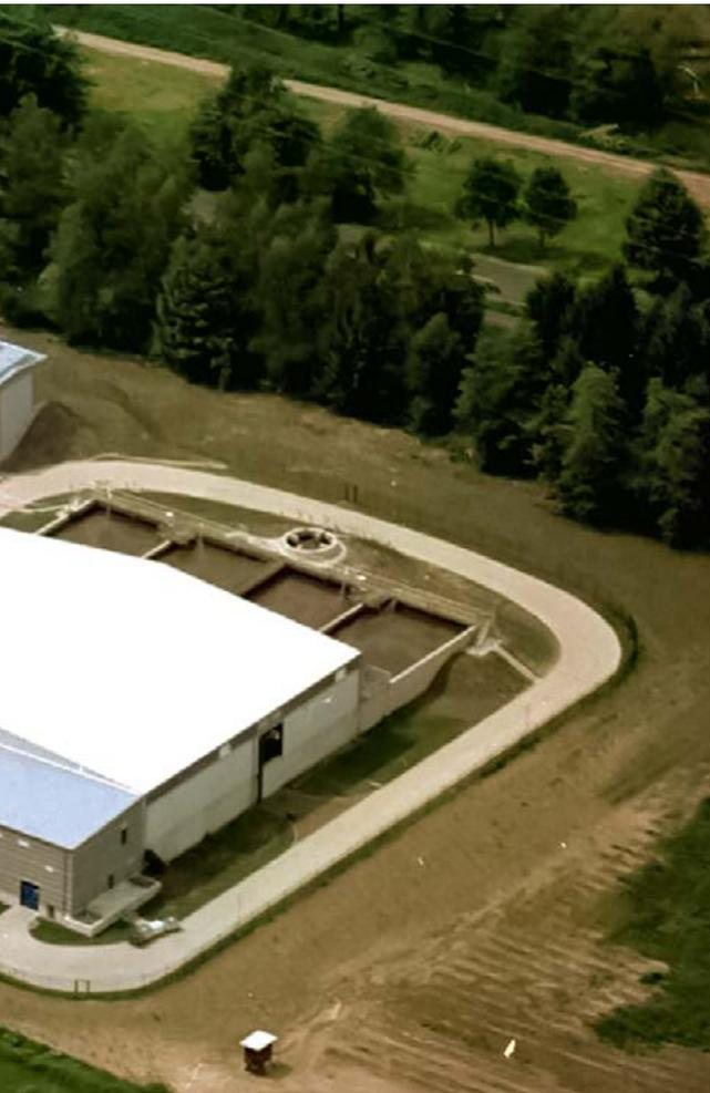
Der Ertftverband betreibt 35 Kläranlagen im Rhein-Erft-Kreis mit einer Gesamtreinigungsleistung von 1.200.000 EW. Kaarst-Nordkanal ist die viertgrößte Kläranlage und eine von drei mit Membrantechnik. Die Anlage reinigt im Jahr rund 5 Mio. m<sup>3</sup> Abwasser. Das Bild zeigt die Bestandsanlage noch vor der energetischen Optimierung.
