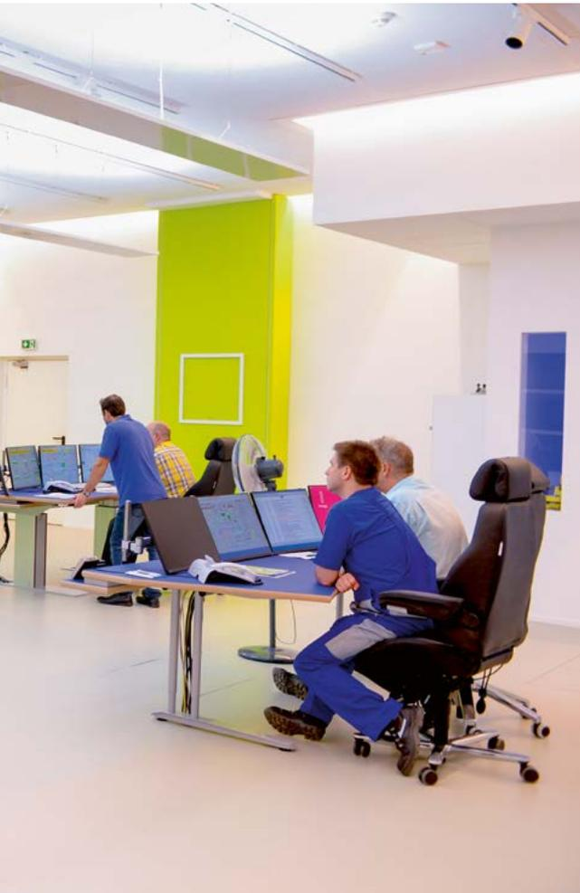
Im Wasserwerk Styrum/Ost befindet sich die zentrale Leitwarte der RWW. Von hier werden alle Wasserwerke sowie weitere wichtige Anlagen, Behälter und Druckerhöhungen überwacht und gesteuert.
