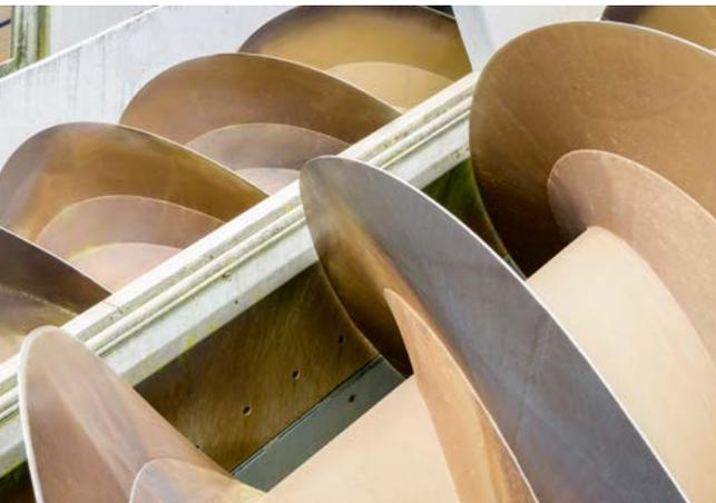
Damit das Abwasser von selbst durch die Anlage fließen kann, wird es im Schneckenpumpwerk um 5 m auf das Anlagenniveau gehoben.
