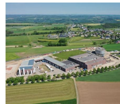
110.000 m³ aufbereitetes Trinkwasser pro Tag ausbaubar auf 150.000 m³/d, das ist eine Steigerung von mehr als 50 % gegenüber der alten TWA. Und die neue Anlage arbeitet wesentlich effizienter. Der Aufbereitungsprozess des Rohwassers konnte von acht Stunden auf unter drei Stunden reduziert werden, das bedeutet auch deutlich weniger Stromverbrauch.
