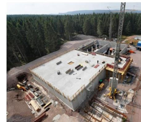
Hier entstand kein neues Hotel für das weltmeisterliche Oberhof. Die Dimension des neuen Hochbehälters wird erst aus der Luft ersichtlich – bevor er unter einem Erdwall verschwindet. Die 2 x 2.150 m³ großen Wasserkammern haben ein Fassungsvermögen von etwa 35.000 Badewannen und damit 30 % mehr als die beiden alten Reservoirs.
